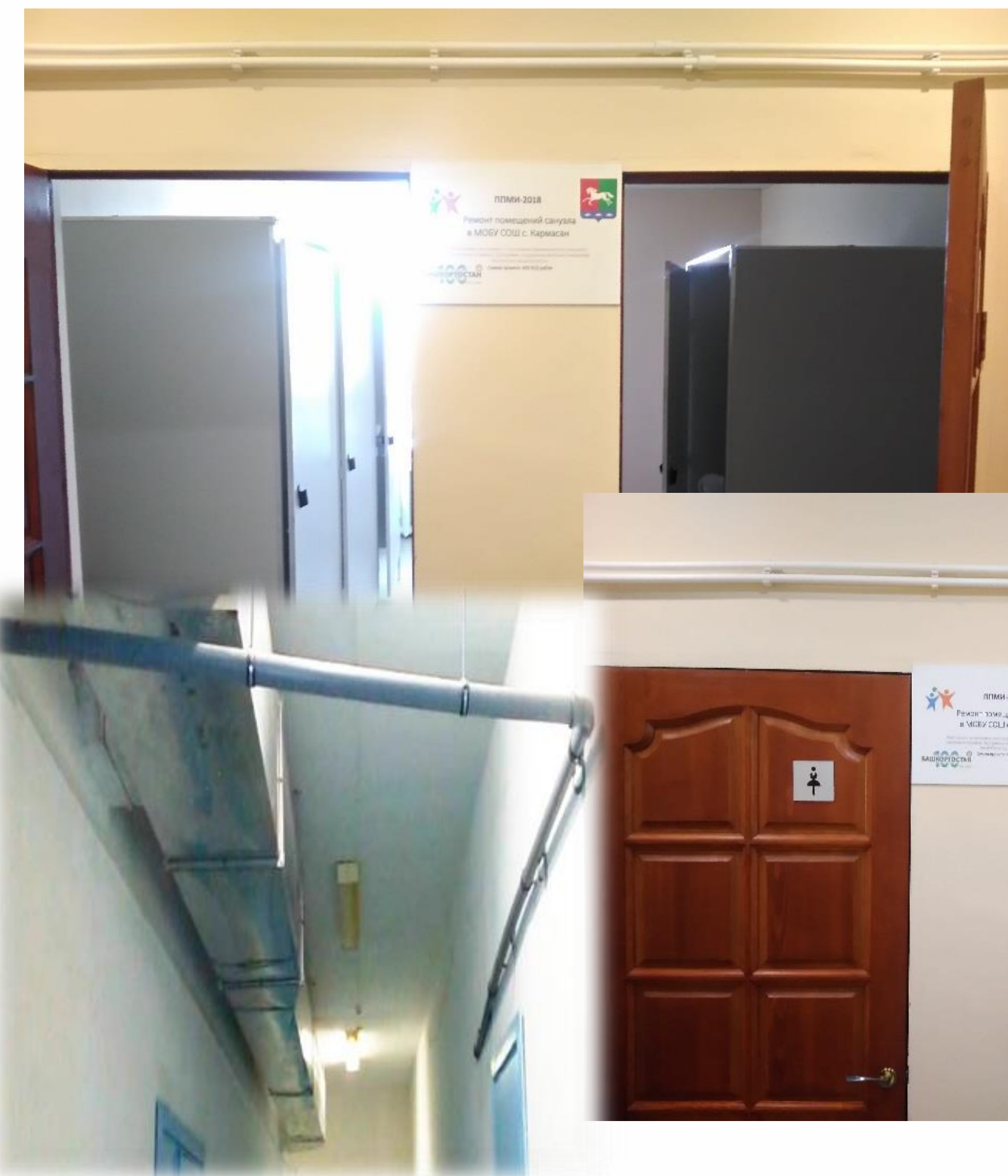
Ремонт помещений санузла в МОБУ СОШ с.Кармасан и ремонт наружной канализации с устройством нового шамбо в МОБУ лицей с.Булгаково
