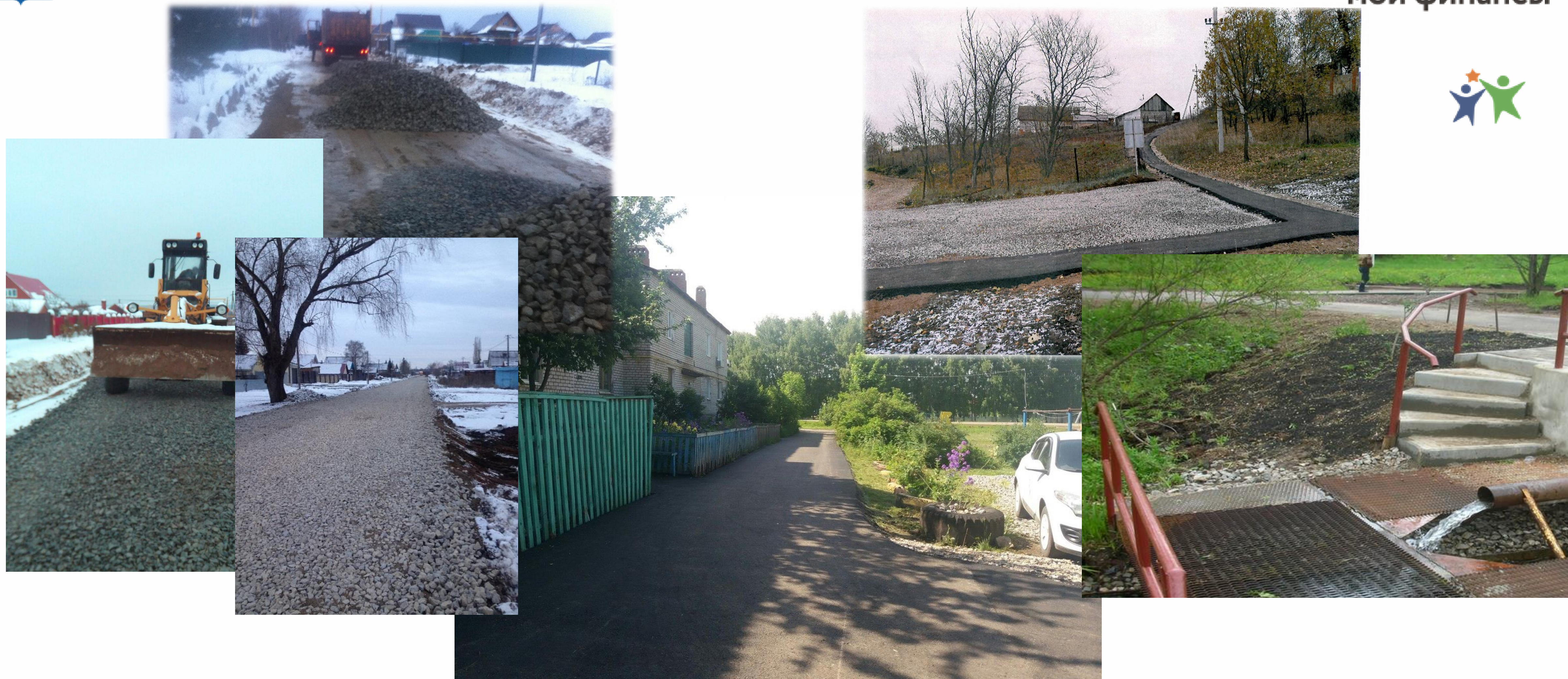
Ремонт дорог в с.Шемяк, с.Черкасссы, с.Нижегордка, д.Шмидтово и пожарный подъезд к реке в д.Таптыково
