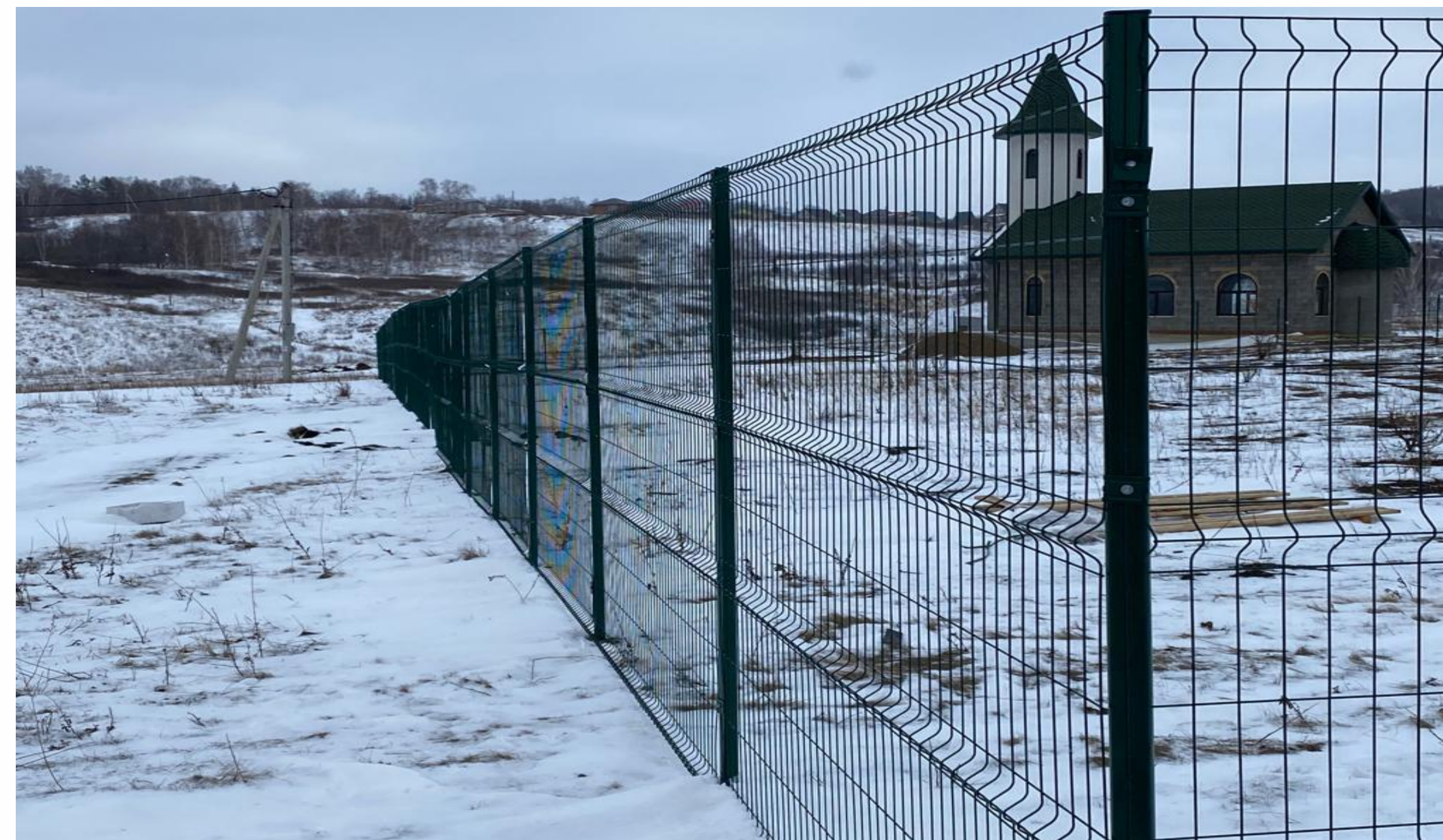
Таптыковский сельсовет. Капитальный ремонт ограждения кладбища деревни Лекаревка
