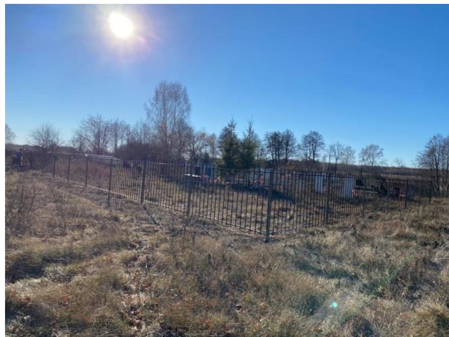
Устройство ограждения кладбища в д. Колокольцево СП Николаевский сельсовет
