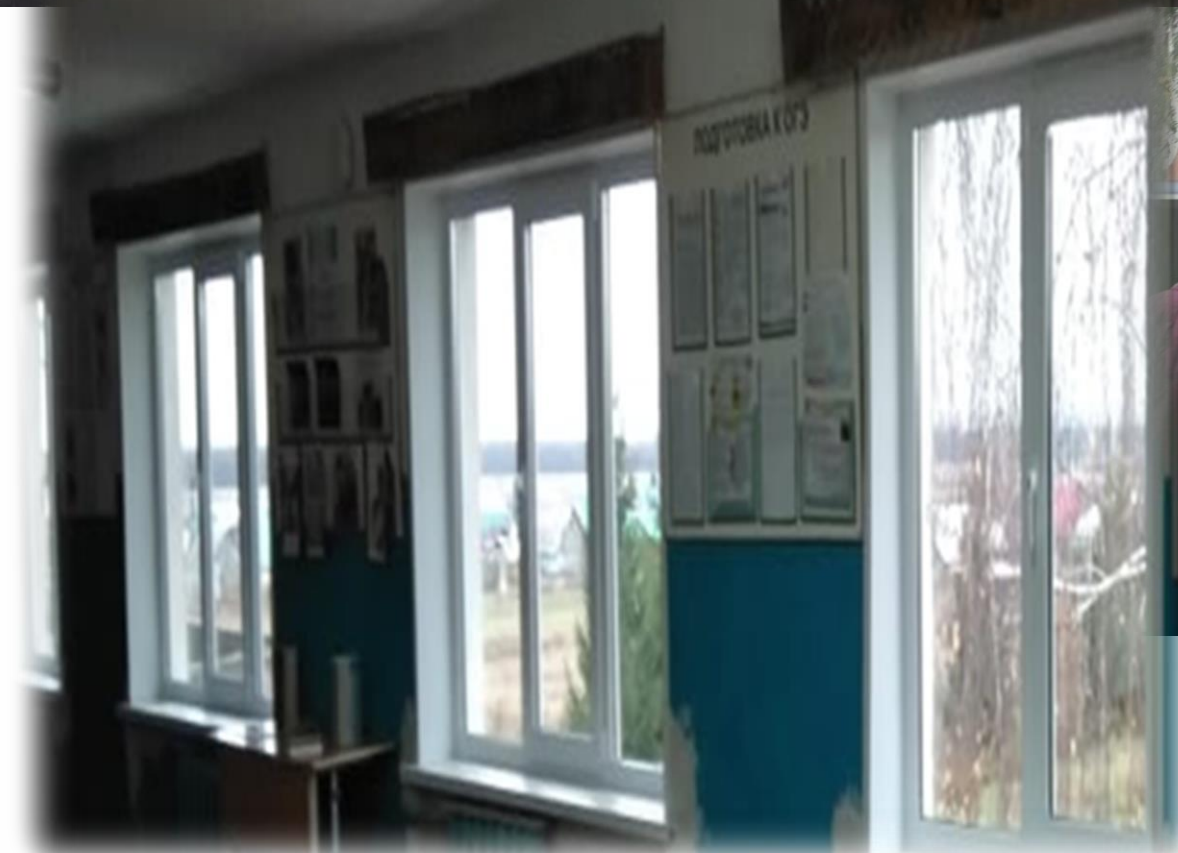
Замена оконных блоков в МОБУ СОШ с.Октябрьский Шемякский с/с и в ООШ с.Кумлекуль Красноярский с/с
