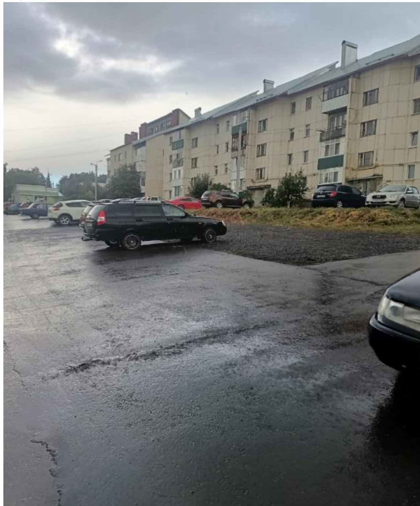
Капитальный ремонт дворовой территории под парковочные места по адресу: Уфимский район, С Авдон, ул.60 лет СССР д.28, 30, 32 и ул.Фрунзе д.7, 9
