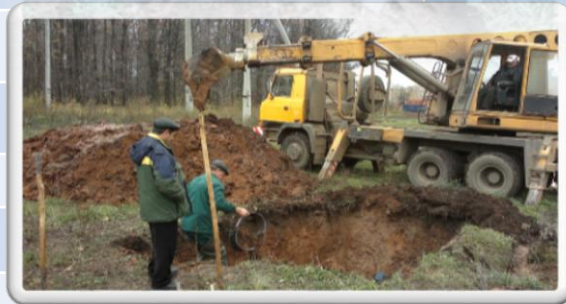
СП Ольховский сельсовет -Ремонт участка наружных сетей водопровода к с.Ольховое (сумма проекта 1041, 8 тыс. руб.)
