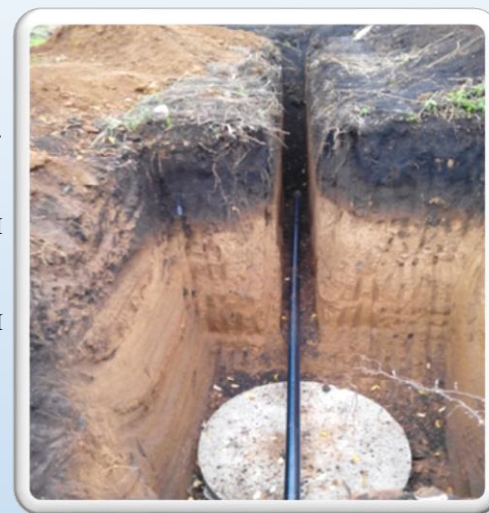
Водоснабжение д. Алексеевка (2 очередь).
